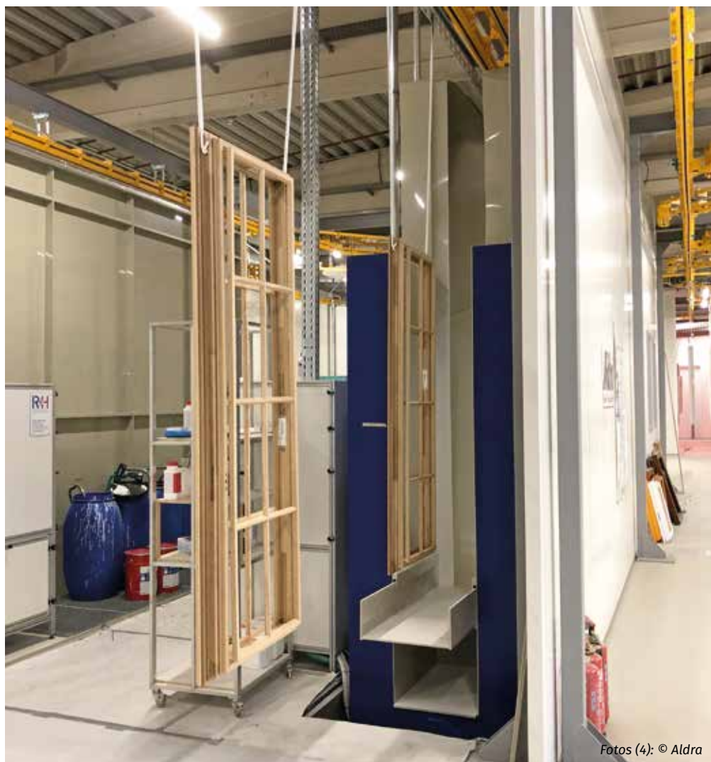
Für den Auftrag der Grundierung auf die Holzelemente stehen Flutanlagen bereit.
